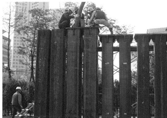
[그림 5] 콘크리트 타설
