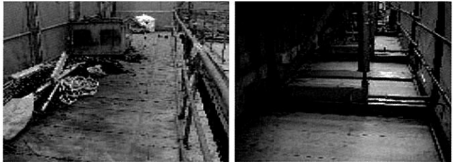
[사진2] 작업발판 자재정리 및 청소상태
