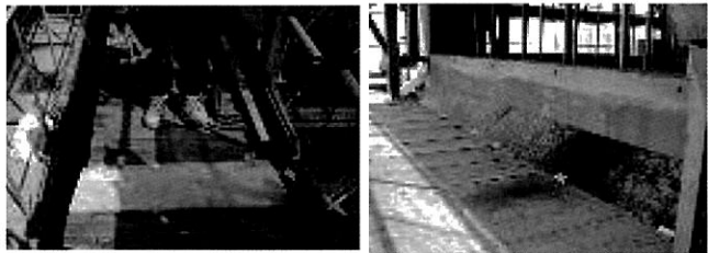
[사진4] 발판과 발판, 벽체와 발판사이 덮개설치
