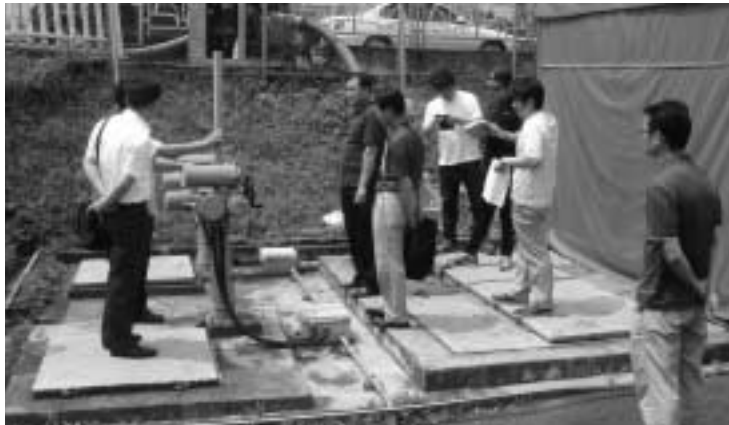
〈춘천 배수펌프시설 현장〉
