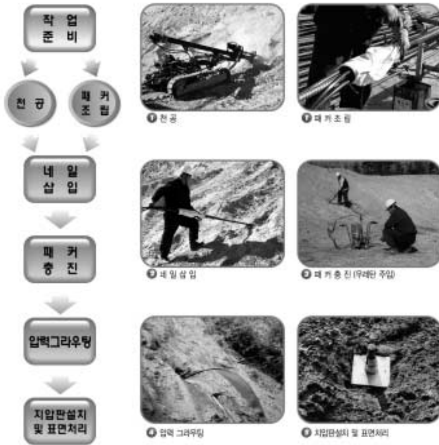
<그림 1.4> 압력식 쏘일네일링 시공순서
