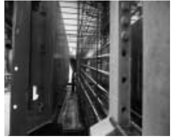
③ 철근 및 쉬스관 조립
