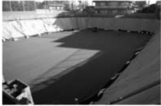
② 보호시트 시공
