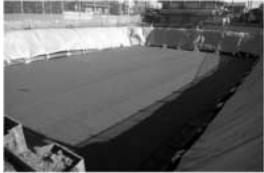
④ 보호시트 시공(2겹)
