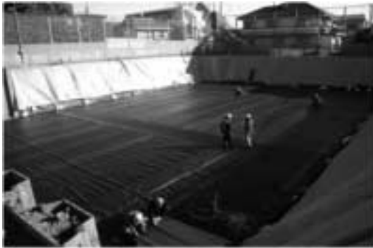
③ 차수시트 시공
