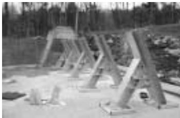
④ 스트럿, 버트레스 부재 설치
