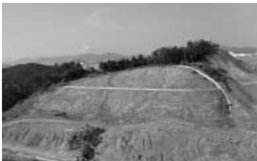
국도 15호선 수해복구 공사
