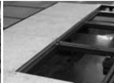
[그림3.3 먼진프레임 상단에 판넬을 설치한 예]
