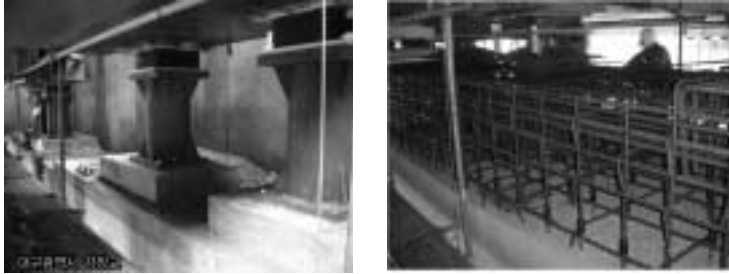
[그림 2] 지지강관 시공 사례
