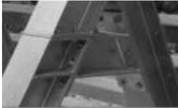
볼트에 의한 모듈조합으로 빠른 시공 및 유지보수 용이
