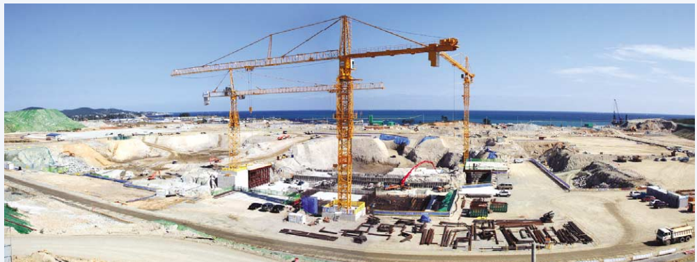
3, 4호기 본관건물 전경(2008. 9)
