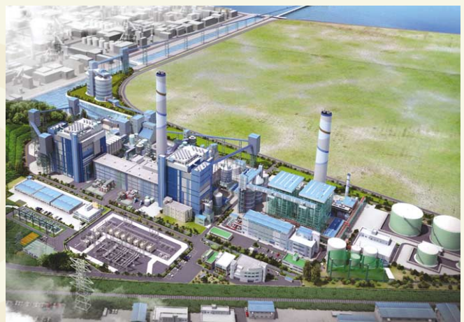
여수화력 건설현장 및 조감도
