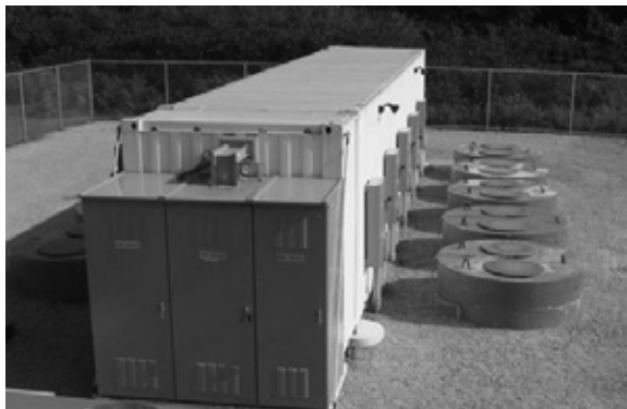
[그림 7] Beacon Power사의 1MW Flywheel System (자료 : Beacon Power)
