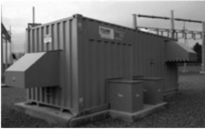
[그림 2] Duke사에 설치된 FIAMM의 222kWh NaS ESS (자료 : Sandia Report, 2013)
