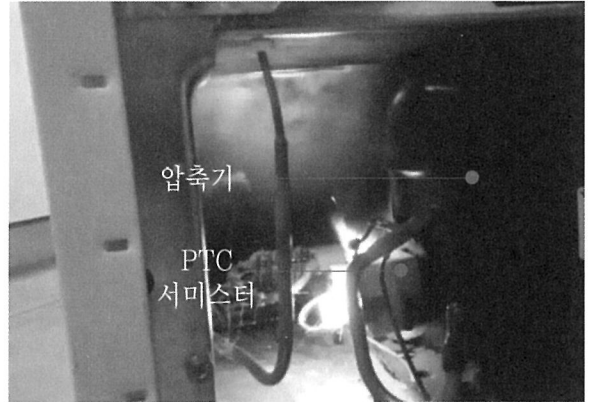
Fig. 1. 냉장고 압축기 전원 접속부 화재
