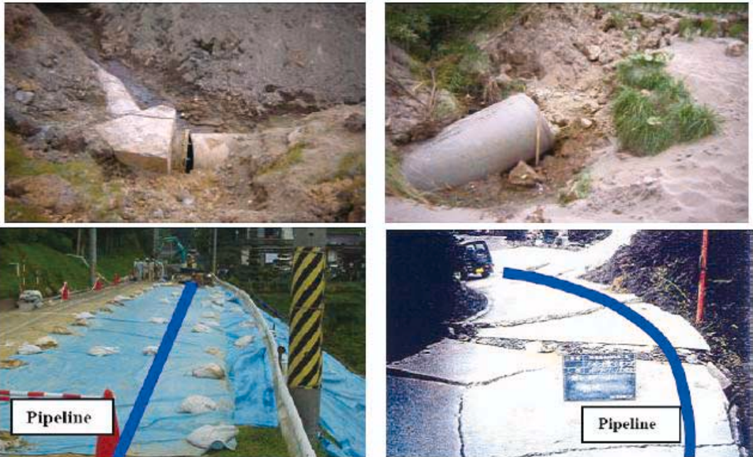
그림 2. 고베 지진으로 인한 관로 파괴
