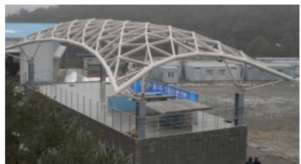
〈그림 15〉 설치 완료된 FREE NODE 지붕
