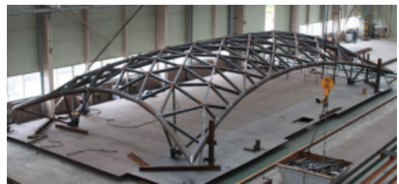
〈그림 14〉 공장 조립중인 FREE NODE 지붕
