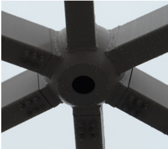
〈그림 16〉 설치 완료된 FREE NODE 디테일
