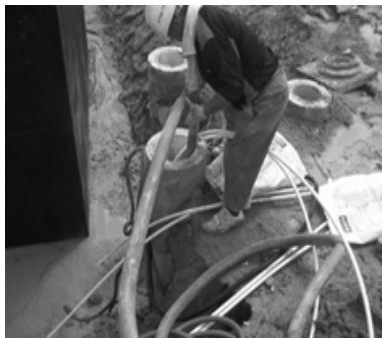
(d) Cement grouting
