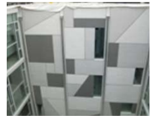
<진공 외단열 시공>
