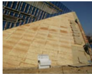
<미네랄 울 단열 시공>
