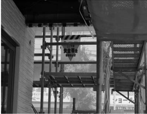
a) 3층 철골 조립식 주택
