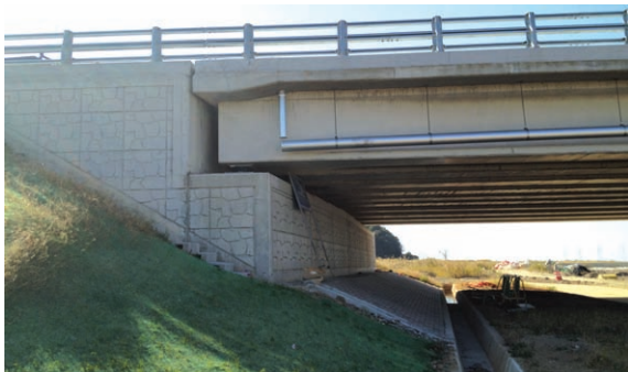
(b) 교대 시공 전경
