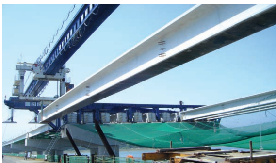
(c) Launcher 이용한 거더 인양 사진 3. Launching 거더 공법
