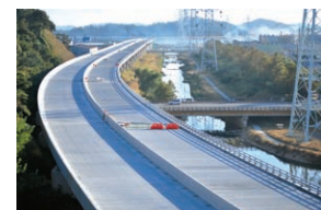
(e) 교면포장 완료
