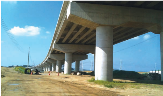
(a) 교각 시공 전경
