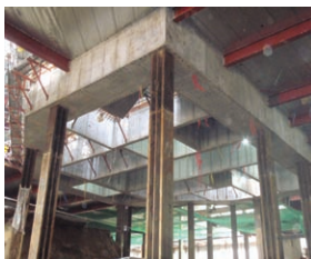
사진 3. 선 시공 코어부분 현장사진-(3)
