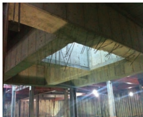
사진 2. 선 시공 코어부분 현장사진-(2)
