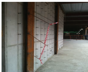
사진 4. 선 시공 코어부분 현장사진-(4)
