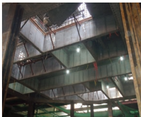
사진 1. 선 시공 코어부분 현장사진-(1)
