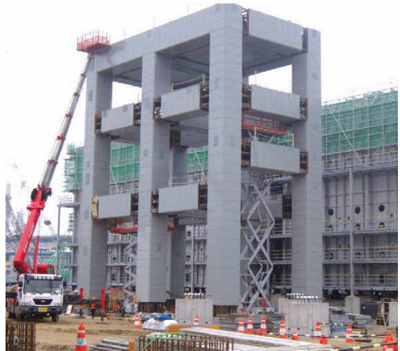
사진 1. 공사 설치 현황
