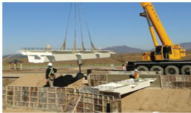
(b) 거더 시공
