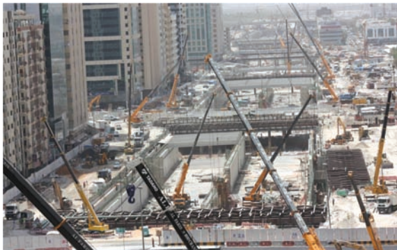
사진 3. Sheikh Zayed 터널 시공
