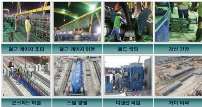
사진 5. AASHTO 프리텐션(Pretension) 거더 제작 과정(총 2,211본)
