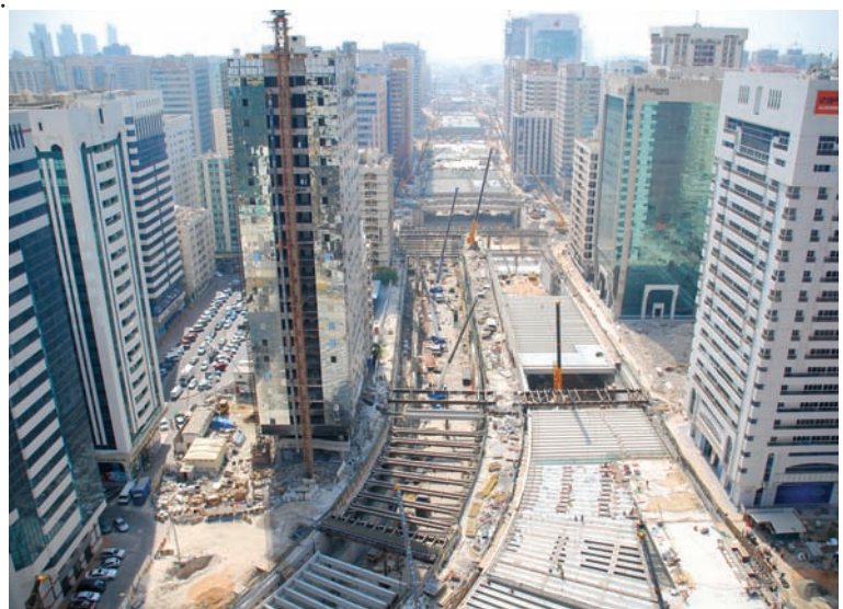
사진 1. 아부다비 Sheikh Zayed 터널 프로젝트(계약시, Al Salam Tunnel)
