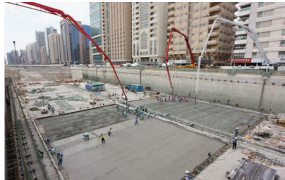
사진 4. 터널 베이스 슬래브 콘크리트 타설
