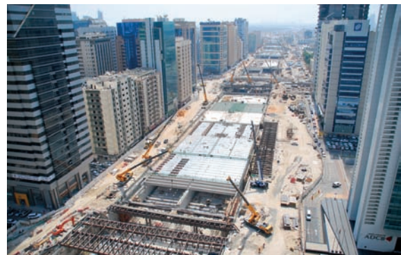
사진 6. 터널 상부 거더 가설 및 루프 슬래브 시공
