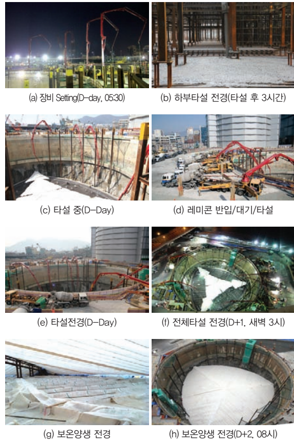
사진 3. 매트기초 실제 타설 진행 현황
