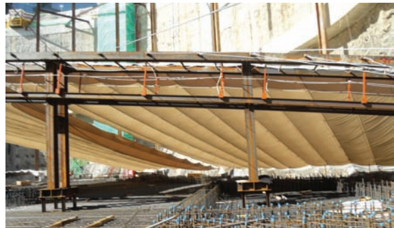
사진 2. 강우대비 천막시설 설치시험 전경
