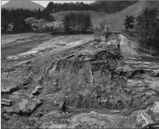
Fig. 12 붕괴된 Fujinuma 본댐 전경 (Pradel et al. 2013)
