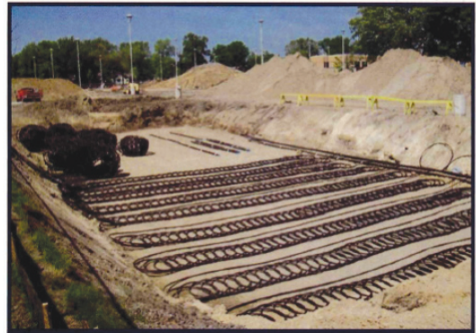
[그림 7] 총 270개의 slinky coil이 9,066 m 2 의 면적에 2 m 깊이로 설치됨
