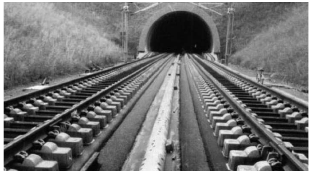
그림 4. GETRAC A3 시공전경
