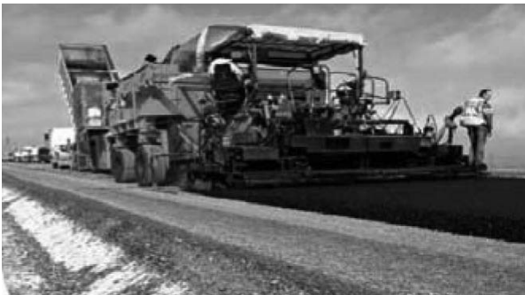
그림 2. 아스팔트 노반부설 전경
