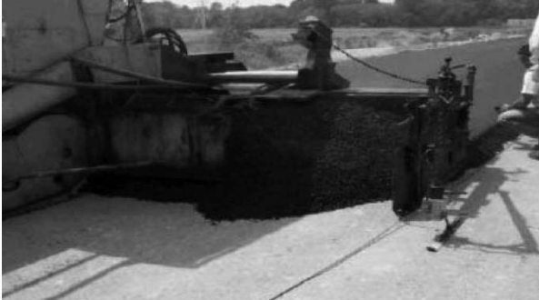
그림 1. 아스팔트 강화노반 부설 전경
