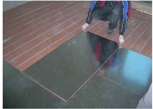
건식 표피 바닥 난방 시공
