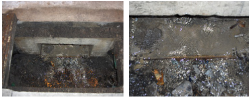
Fig. 11-1 집수정 연결 배수관 시공 사진
