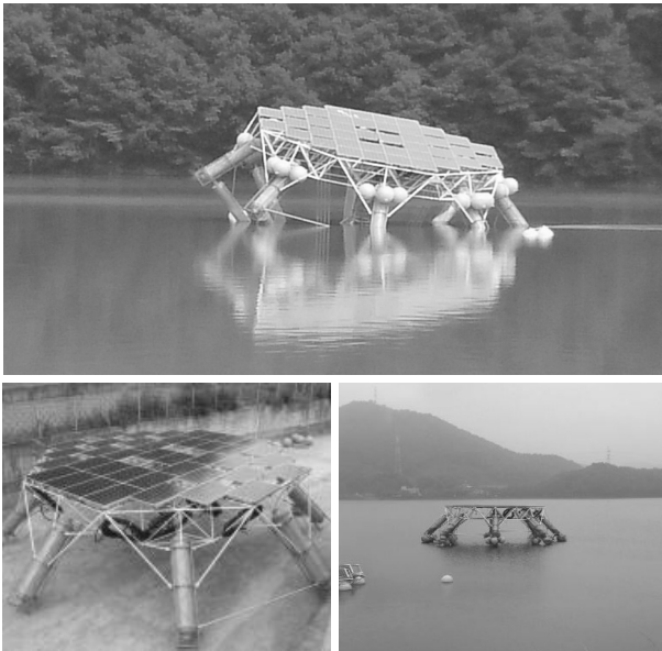
Fig. 5. 10 kW 용량 수상 태양광 발전 추적 장치 설치모습
