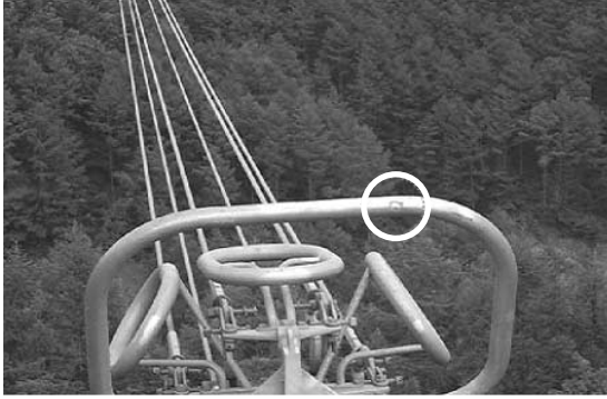
[그림 3] 낙뢰로 인한 765kV 애자장치 섬락고장
