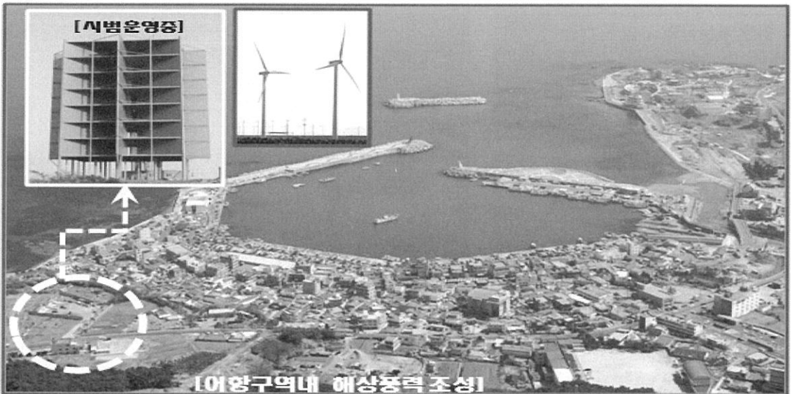
〈그림 4〉 정자항 전경 및 해상풍력 발전시설
