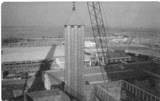
< 사진 7. 크레인을 이용한 집진판 설치 모습 >
