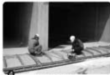
상부 철판패널 설치
