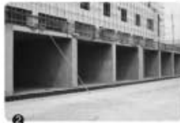
기초 콘크리트 타설
