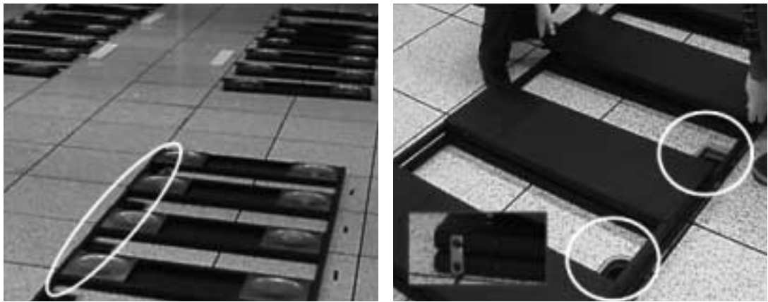
하판부 조립 후 Ball을 넣고 상판부를 올리는 모습
