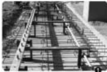
고정 골구 및 공기 이송장치 설치
