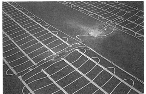
[그림 2] 설치 사례(노면 결빙 예방을 위해 노면을 0.5도 이상 유지하여 차량이나 보행자의 안전을 확보함)
