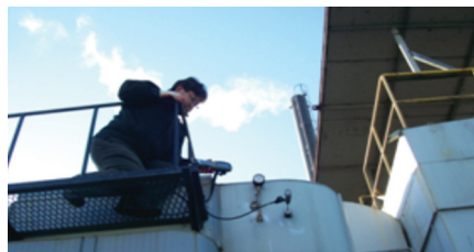
〈그림 5〉 스팀보일러 연소효율 측정
