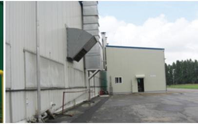
〈그림 12〉 공정측에 기계실 설치
