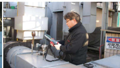
〈그림 6〉 열매체보일러 연소효율 측정
