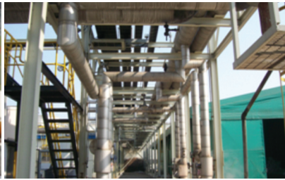
〈그림 8〉 열공급용 배관 설치사진
