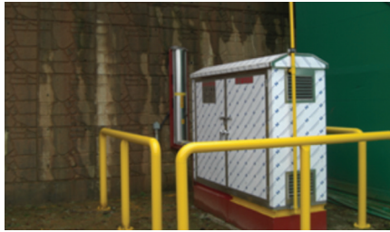
〈그림 11〉 LNG 관로 설치
