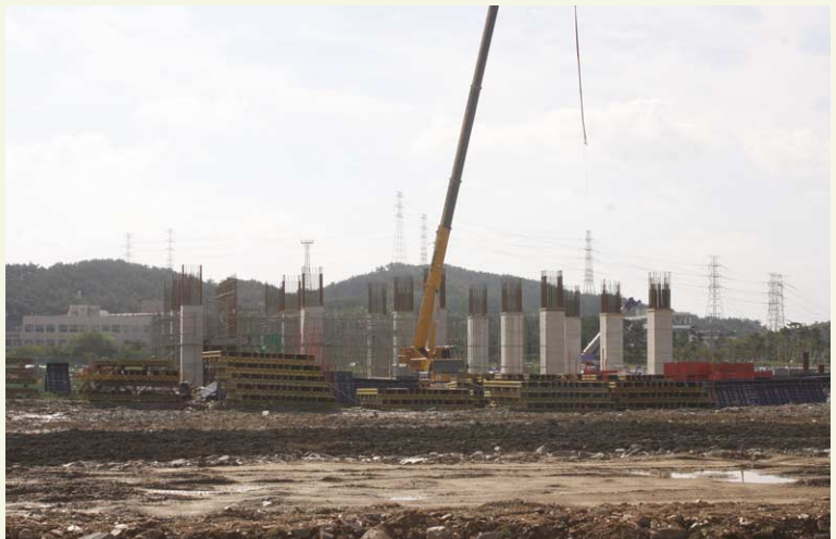
IGCC 실증플랜트 건설현장
