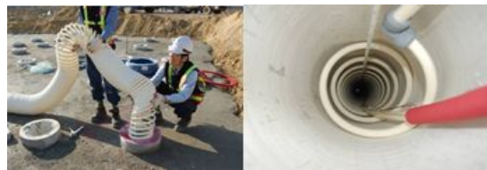
그림 1. 나선형 파이프 지중열교환기 설치
