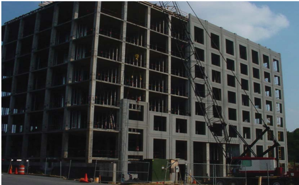
그림 7. Proximity Hotel에 쓰인 프리캐스트 콘크리트 패널 시스템
