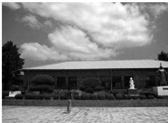
그림 2. 빗물저금통이 설치된 건물 전경
