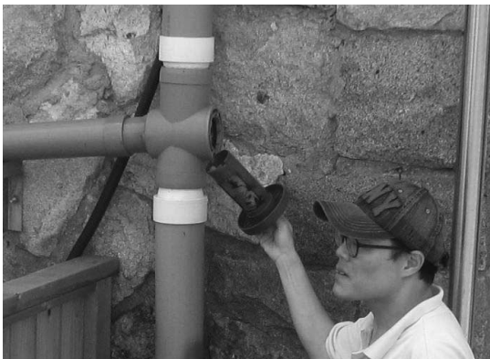
그림 8. 빗물 필터 상태 확인 모습
