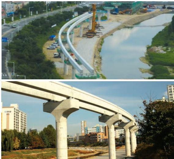
사진 2. 곡선 빔 전경
