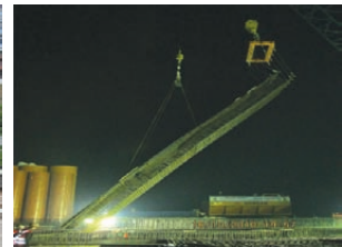
사진 6. 철근망 인양 전경
