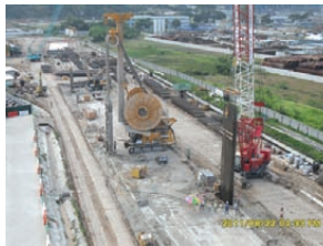
사진 5. 철근망 근입 전경
