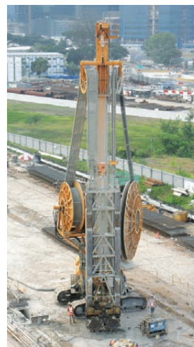
사진 1. 굴착 장비(BC cutter)
