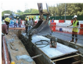
사진 4. 가이드 월 시공 전경
