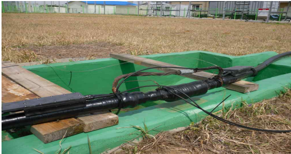
그림 8. 직선접속부 실증시험장 설치 Fig. 8. Installation of splice in test-bed
