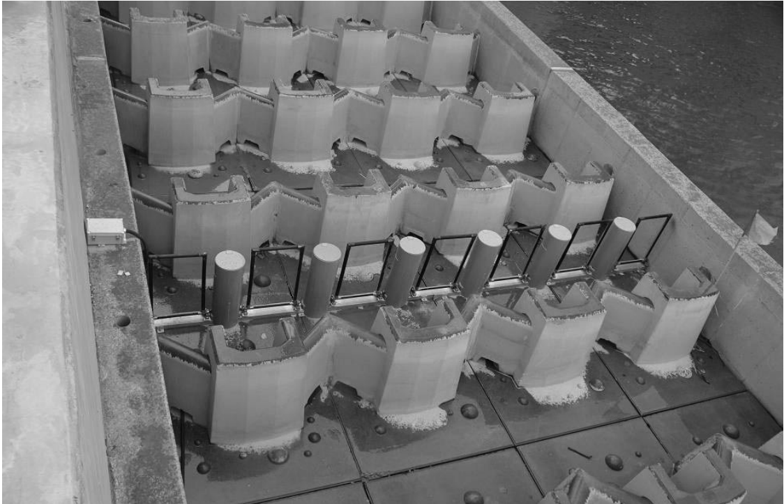
그림 2. PIT tag 안테나가 설치되어 있는 공주보의 아이스하버식 어도 (중양)
