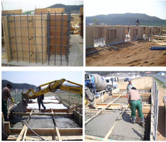
[그림 9] 매립회 콘크리트 구조물 제조
