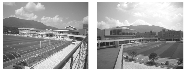
교사 및 운동장의 환경 개선 신축된 체육관과 기숙사 그림 3. 속리산중학교의 신축 및 기존시설 리모델링 사진
