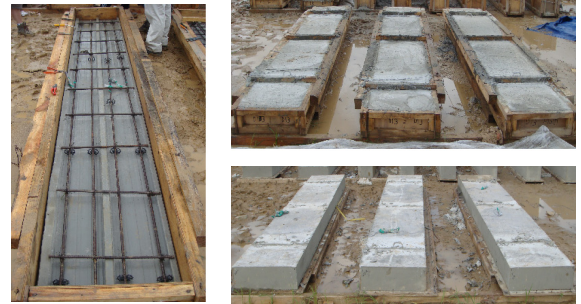
(a) ECC 패널 (b) 상부 콘크리트 타설 및 철근 배근 및 시험체 완성
