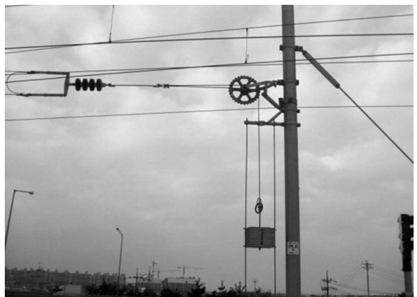
그림 1. 활차식 자동장력조정장치
