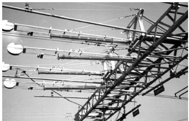
그림 5. 코일스프링식 자동장력조정장치(중국제품)
