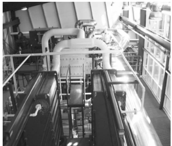
[그림 6] Iceland의 2 MW급 카리나 사이클 이용 지열발전 모습
