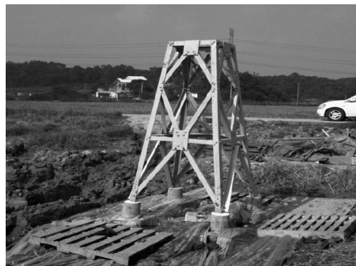
(d) 시험체 조립 완료
