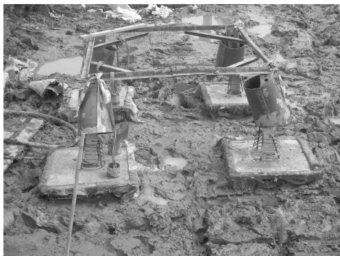
(c) 기초콘크리트 타설
