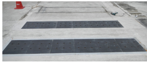
Fig. 8 개선된 양단지지 방식의 벤딩 플레이트 고정식 축중계 시험시공 사례
