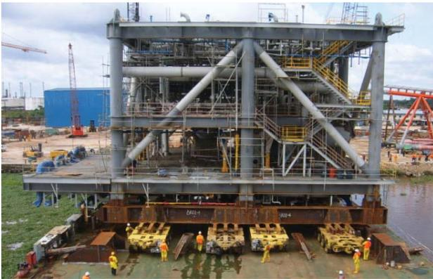
그림 7. Load Out 사진
