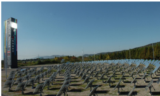
Fig. 3 국내 최초 대구 200 kW 중앙흡수기형 태양열 발전소
